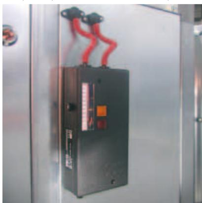
Манометр перепада давления (контроль фильтра)
