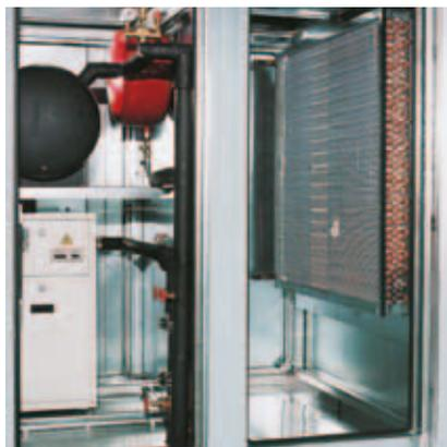
Охлаждение с модулем подготовки холодной воды
