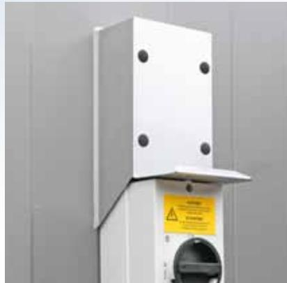
Погодозащищенное исполнение, ремонтный выключатель
